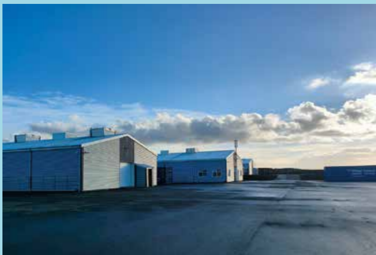
アイスランドのデータセンター
