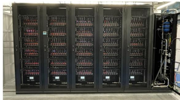
松江DCPに設置された直接水冷のMN-Core 2サーバ30ノードおよび水冷設備
