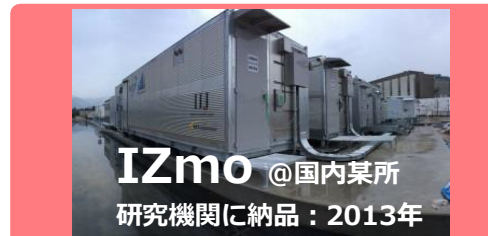
IZmo @島根県松江市 外気冷却コンテナ型DCの実現
