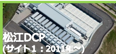
IZmo @島根県松江市 外気冷却コンテナ型DCの実現
