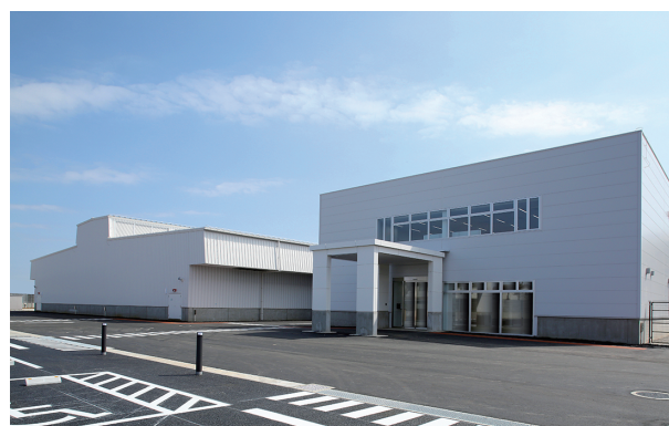
2019年に運用開始した白井データセンターキャンパス
