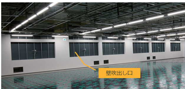
図-11 壁吹出し空調の開口
