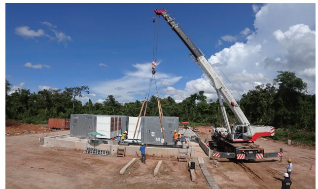
図-3 クレーンによるコンテナ設置 ～数日で設置作業完了。現地工期の大幅短縮～
