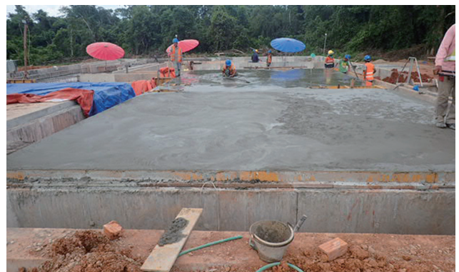
図-1 基礎コンクリート工事 ～大きな日傘で日陰を作りながらの作業～
