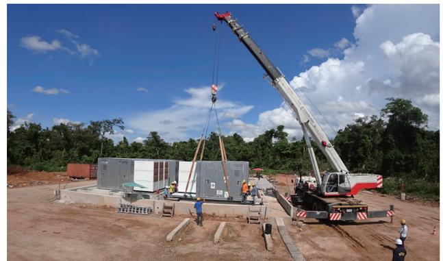
図-3 クレーンによるコンテナ設置
