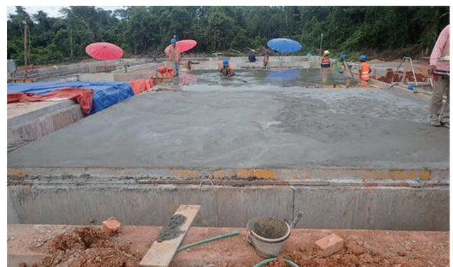
図-1 基礎コンクリート工事
