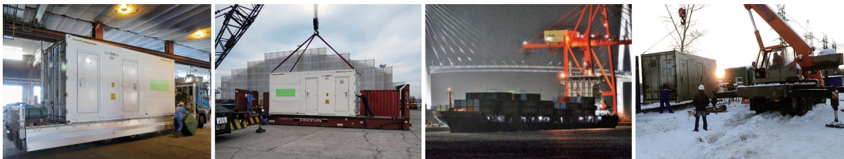
図-3 モジュール工場から出荷→横浜港でコンテナ船に搬入→横浜港からウラジオストクに向かうコンテナ船→現地での設置作業
