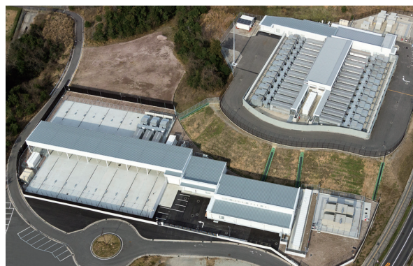
図-2 松江データセンターパーク
