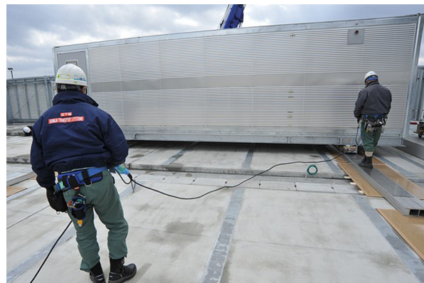
図-6 搬入されたコンテナ設置風景
