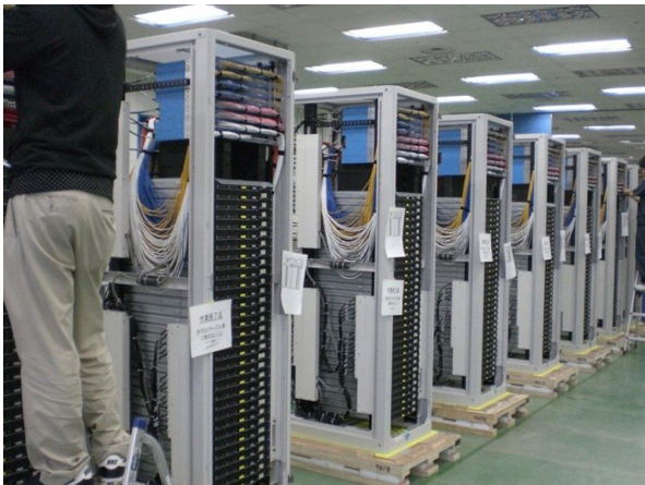
図-9 サーバ工場内でのラッキング作業
