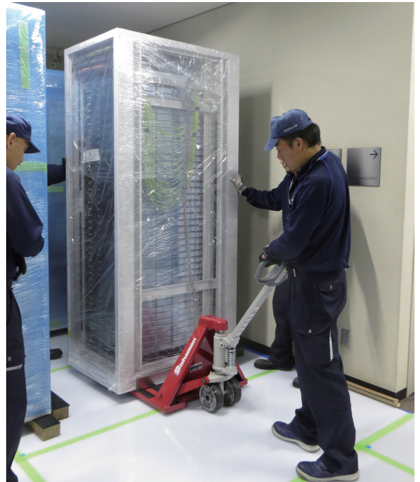
図-10 ラック搬入の様子
