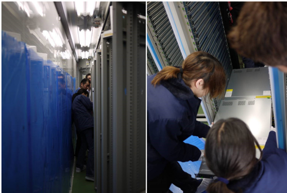
図-8 コンテナ内作業と初期不良対応の様子
